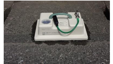
本体箱の設置
