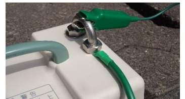
接地線の接続
