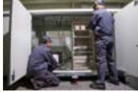
工事・システム導入
